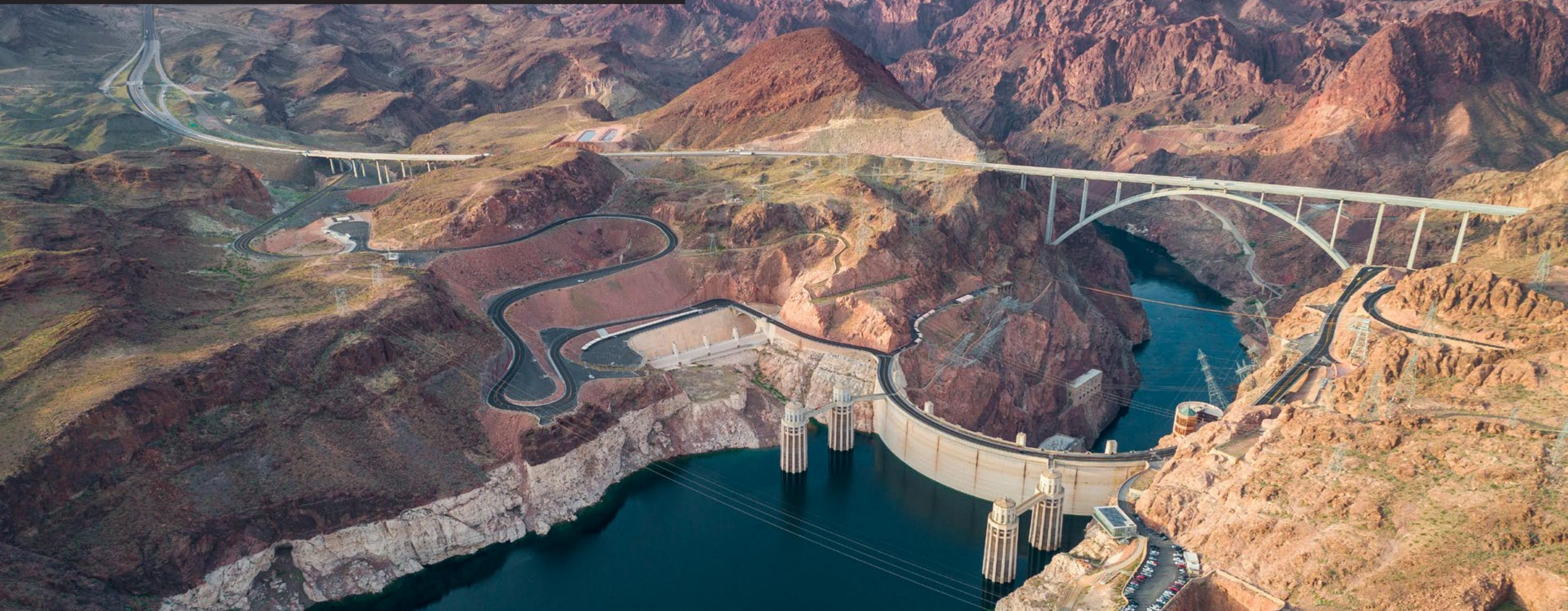
Com um comprimento de 380 metros, uma altura de 110 e uma largura de 200 metros na base, é uma das maiores represas do mundo. Sua construção começou em 1931 e terminou em 1936, dois anos antes do previsto e com um custo inferior ao planejado. Durante sua construção foram usadas técnicas que não haviam sido testadas até o momento.
